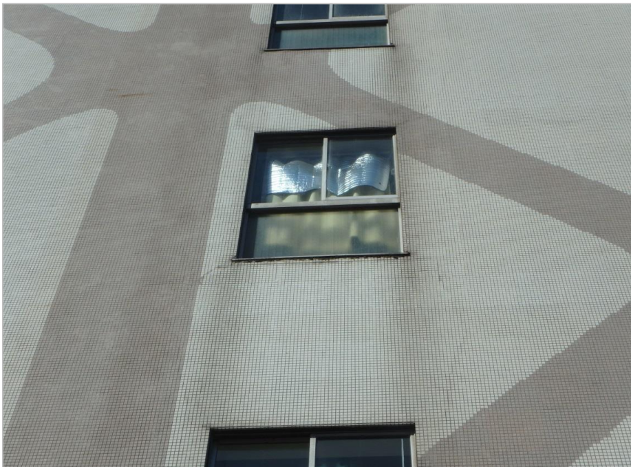
東面 駐車場側
