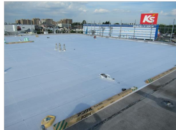
下地シート張り
