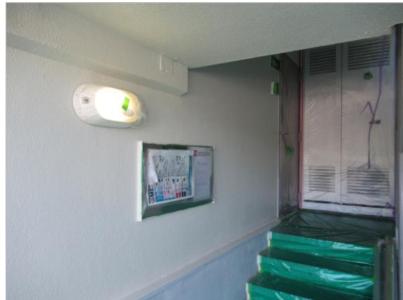
外壁 シリコン 中塗り
