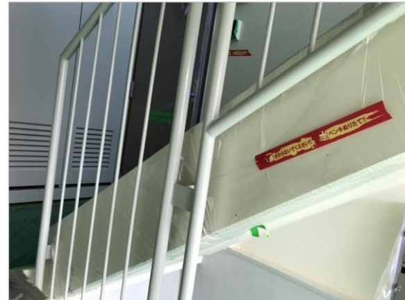
階段手摺 施工後
