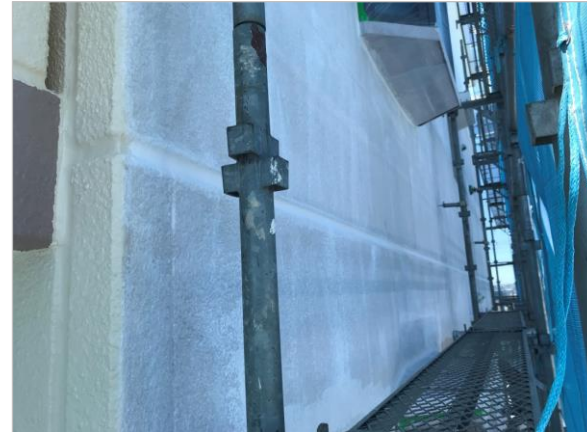
外壁 下地 フィラー塗装
