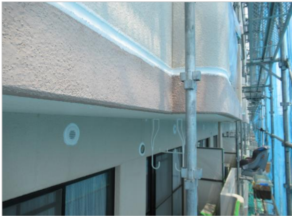
シーリング 打ち替え 施工後
