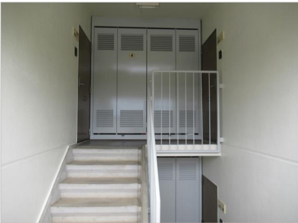
シーリング 打ち替え 施工後
