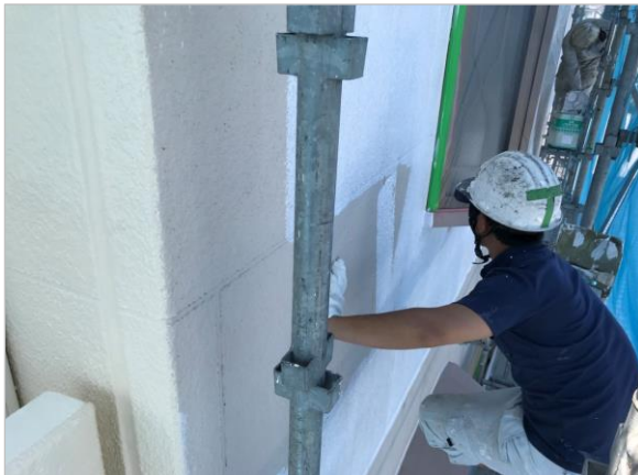
外壁 下地 フィラー塗装
