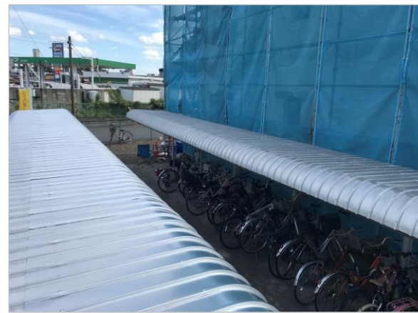
駐輪場屋根 仕上り
