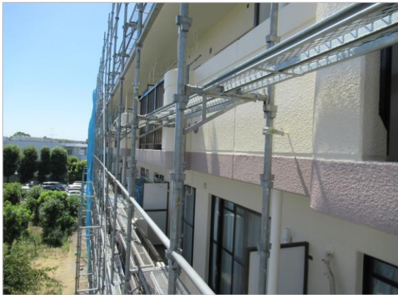
シーリング 打ち替え 施工後
