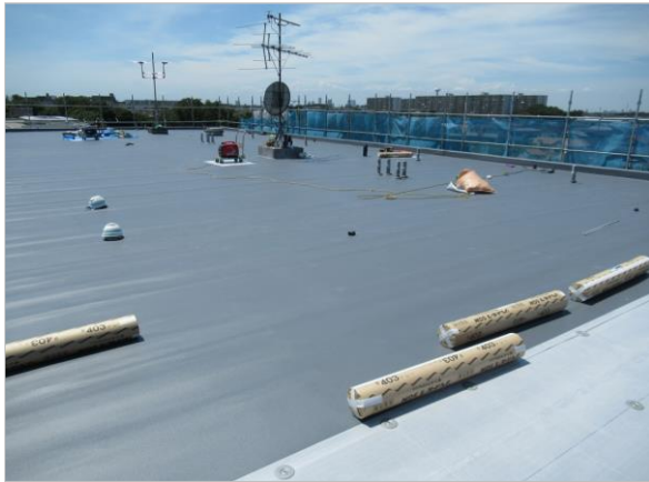
塩ビシート張り
