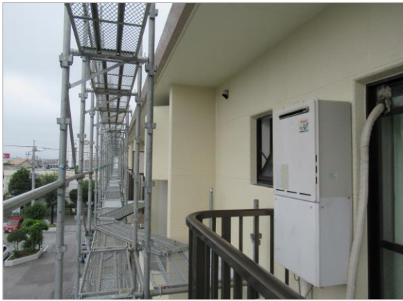
外壁 シリコン 上塗り 施工後
