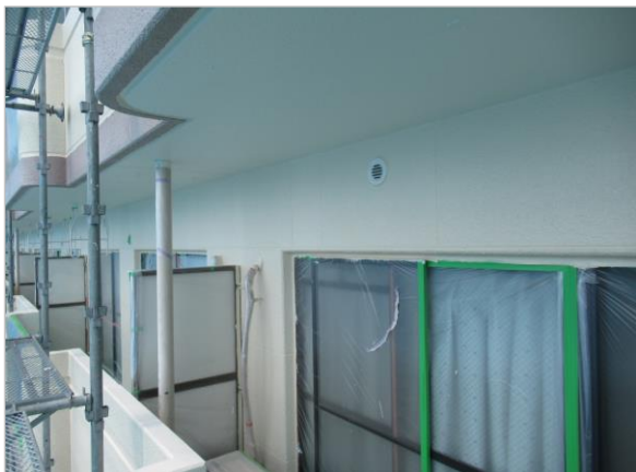
外壁 シリコン 中塗り
