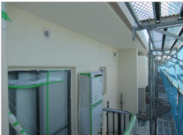
外壁 シリコン 中塗り
