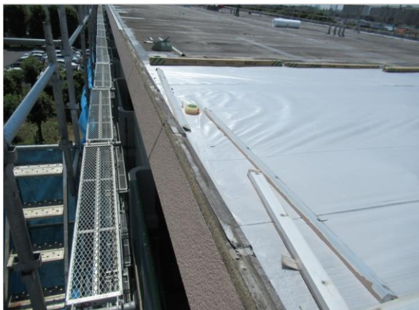
下地シート張り
