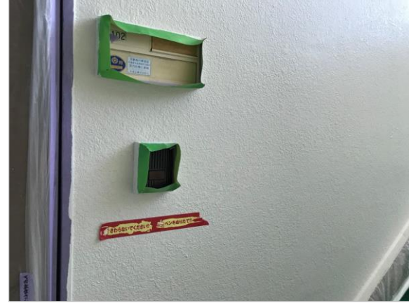
階段外壁 施工後
