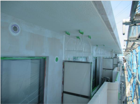
外壁 下地 フィラー塗装
