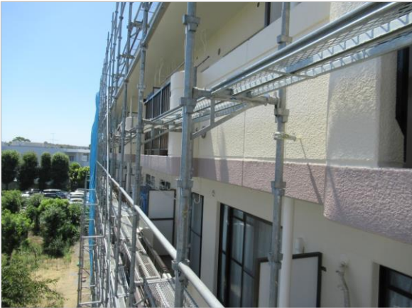
外壁 シリコン 上塗り 施工後
