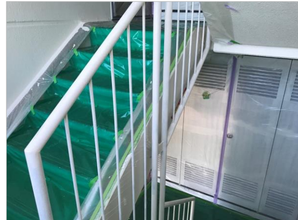
シーリング 打ち替え 施工後
