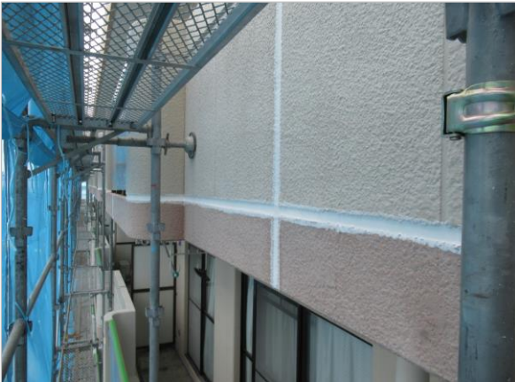
シーリング 打ち替え 施工後
