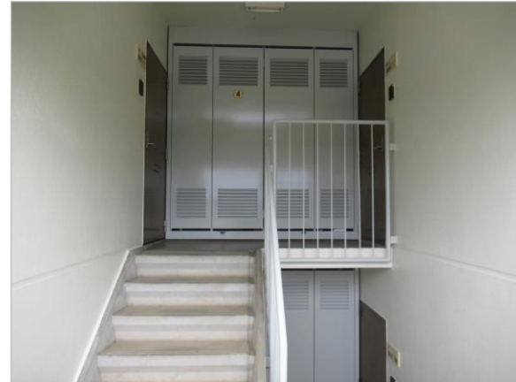
PS扉・階段手摺 施工後
