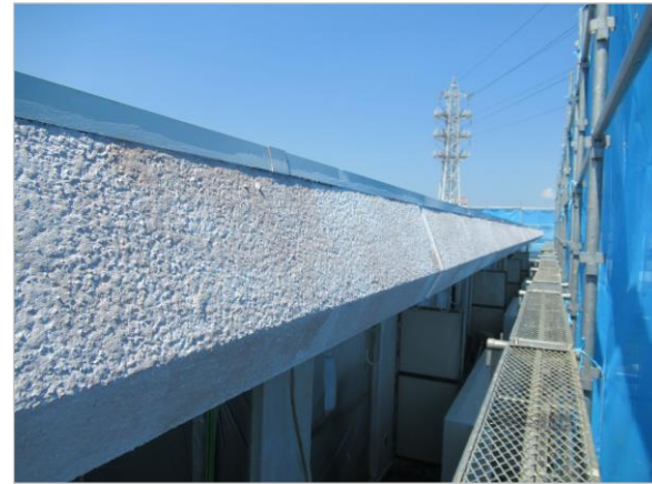
外壁 下地 フィラー塗装
