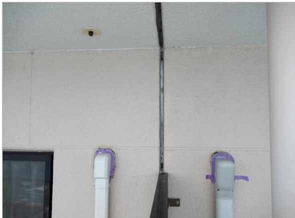
シーリング 撤去
