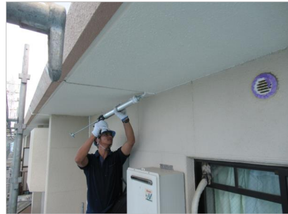
シーリング 打ち替え
