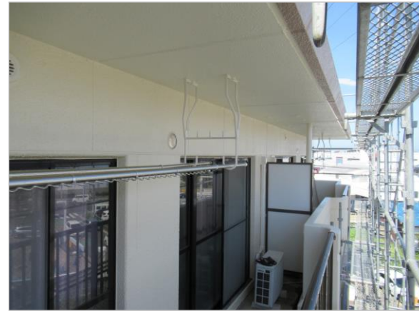
外壁 シリコン 上塗り 施工後
