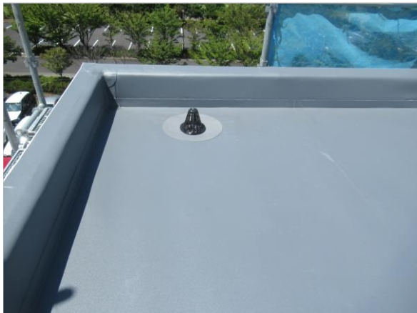
新規 ドレン設置
