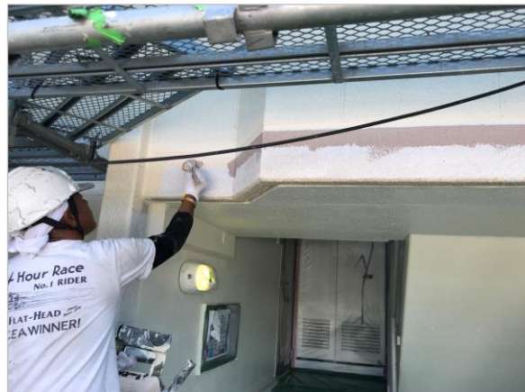
外壁 シリコン 中塗り
