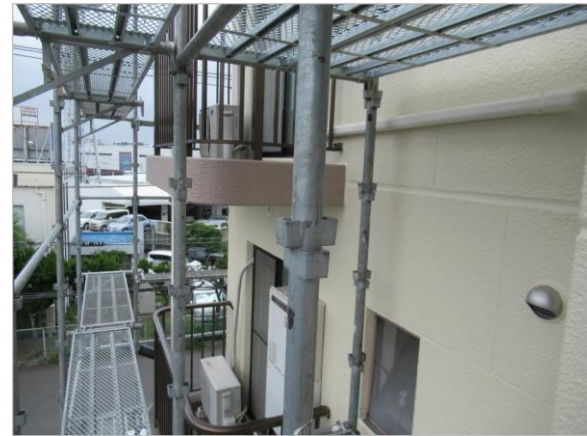
外壁 シリコン 上塗り 施工後
