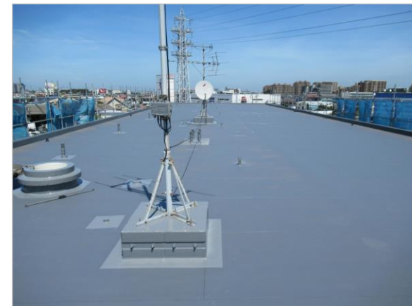
架台・ハッチ廻り ウレタン防水工事
