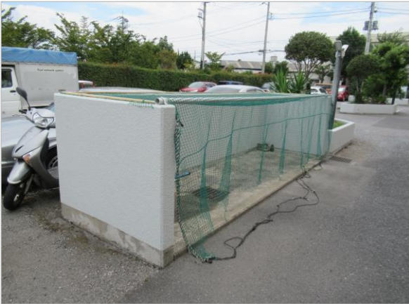
ゴミステーション 施工後
