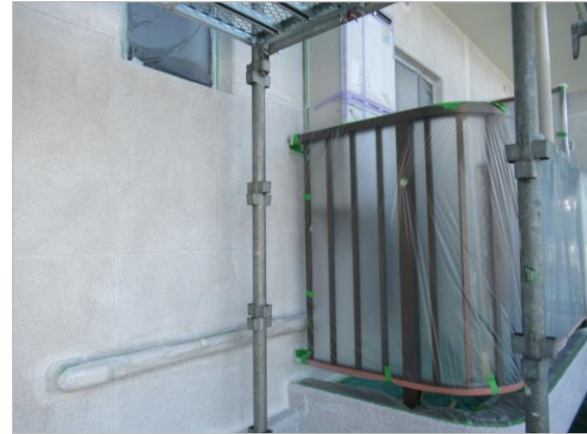
外壁 下地 フィラー塗装
