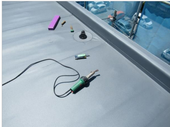
貼り合わせ部 溶接
