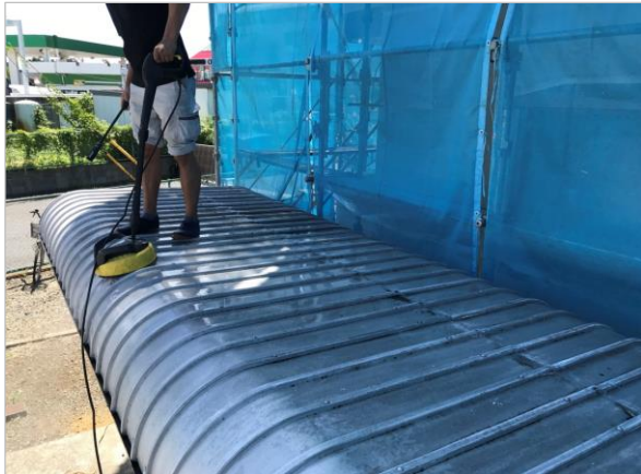
駐輪場屋根 洗浄
