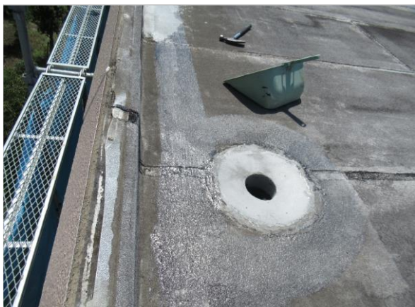
ドレン・金物撤去 シーラー塗布
