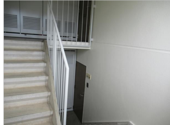
外壁 シリコン 上塗り 施工後
