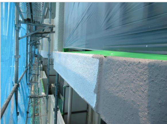
外壁 シリコン 中塗り
