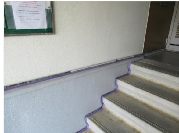
シーリング 撤去
