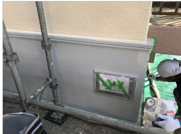
外壁 シリコン 中塗り
