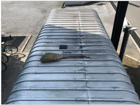
駐輪場屋根 ケレン 清掃
