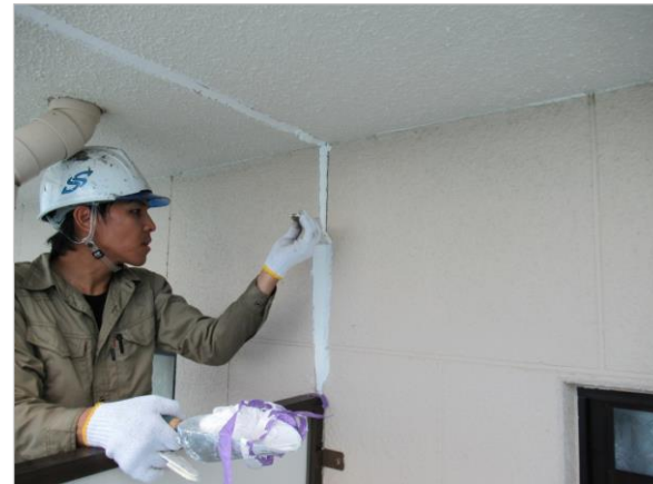
シーリング 打ち替え
