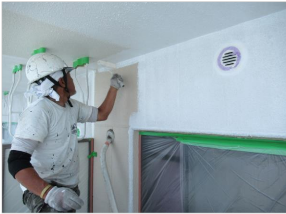
外壁 下地 フィラー塗装
