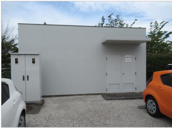
変電設備 施工後
