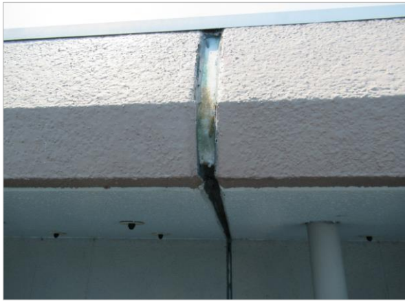
シーリング 撤去
