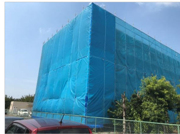
メッシュ養生 駐車場面 ブルーシート設置
