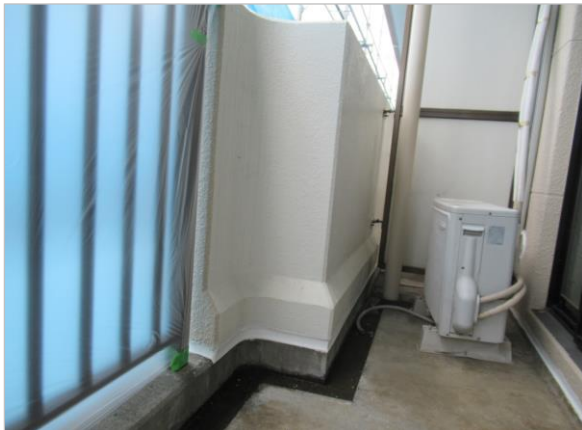
シーリング 打ち替え 施工後
