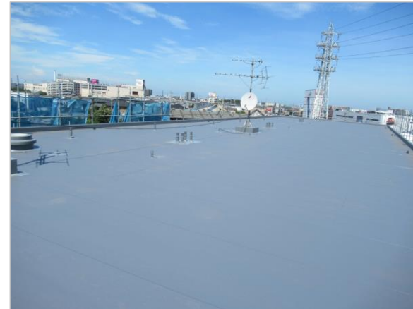
屋上防水 施工後
